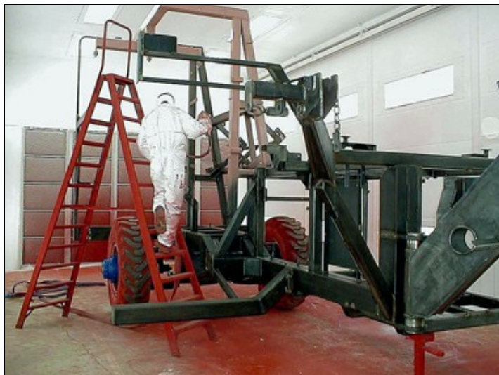
L'investissement dans une nouvelle chaîne de laquage s'inscrivait dans le cadre d'une optimisation générale du processus de production interne
